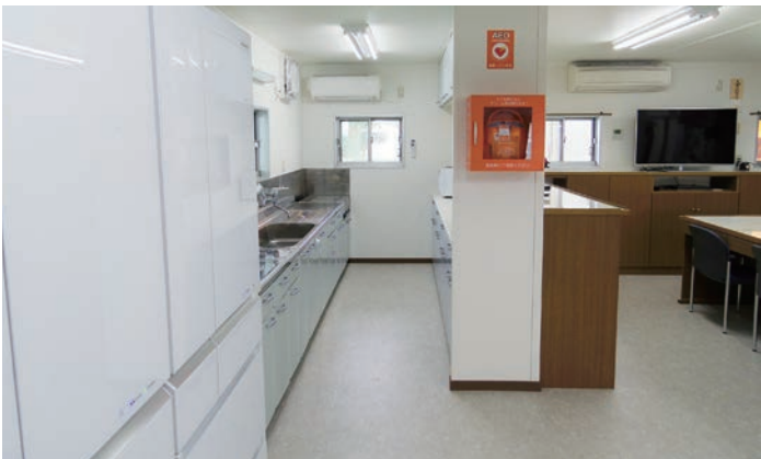
オール電化キッチン
