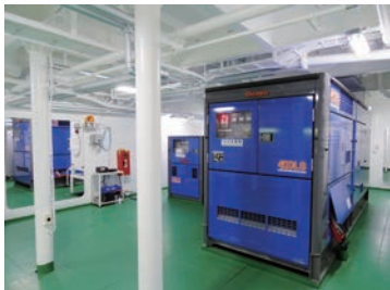
IMO 排ガス2次規制発電機及びHHOガス発生装置
